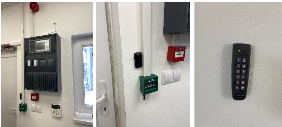
Figura 36 – Componente ale sistemului de securitate local, instalate și funcționale
